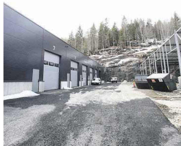
BYGGER: Bygget til venstre er Agder Lagers første på Rødmyr. Bygg nummer to er under bygging ved siden av dette.
